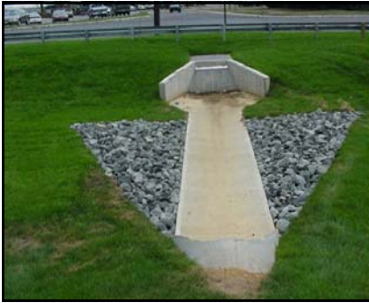
Rip Rap Apron
